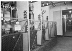
Fig. 4. Vue partielle de l'appareillage FTTE. Fonctionnement FTTE (10/10000 V, 400 MHz) avec deux encoches de charge à six composants. Dans le fond du fond, une partie des filtres pour le tenseur anodique 10-0-10 FTTE.
